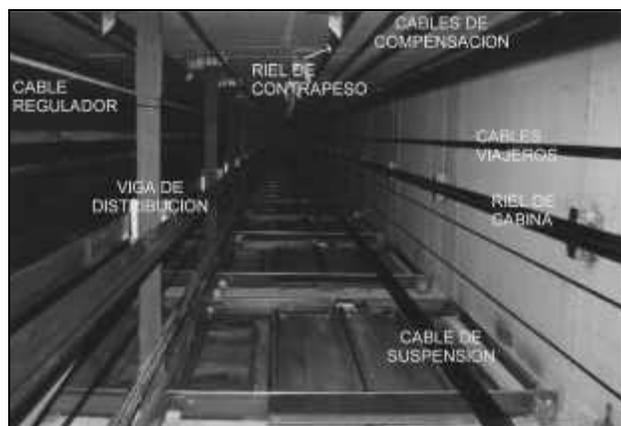
Fig.2.3: Ducto de circulación y componentes.
