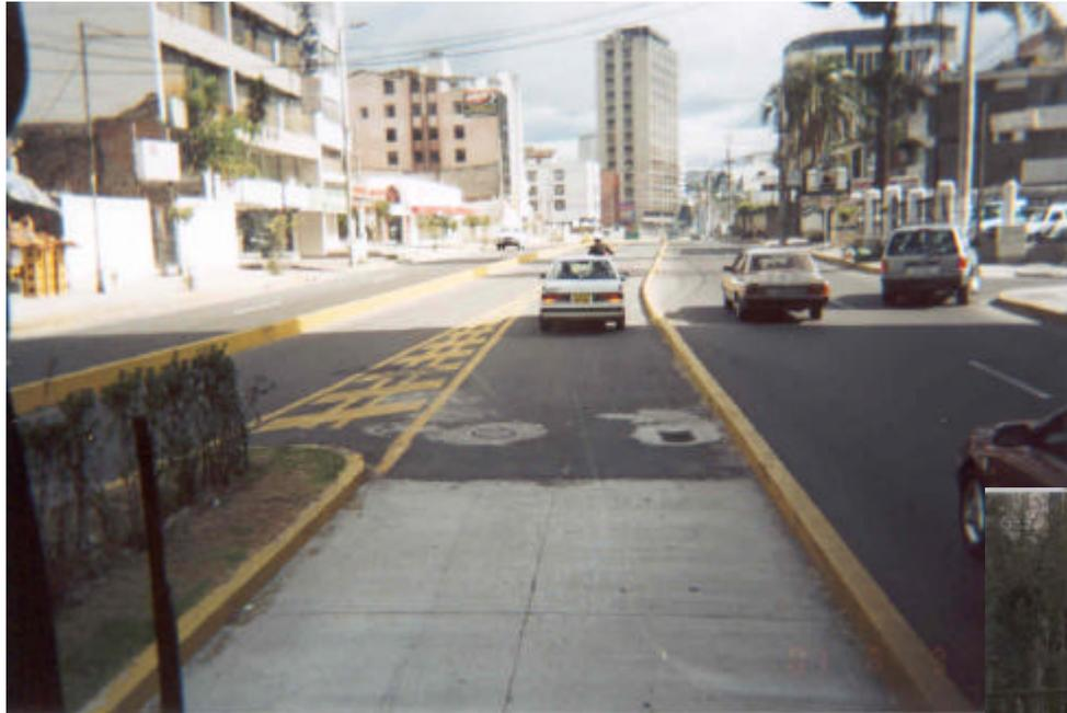
La segregación física del corredor de la ECOVIA considera una solera de contención – segregación del tipo cuadrada. Este tipo de segregación física separa efectivamente la pista del trolebús del resto de la circulación vehicular, impidiendo conflictos concurrenciales y funcionales entre ambos modos de transporte.
