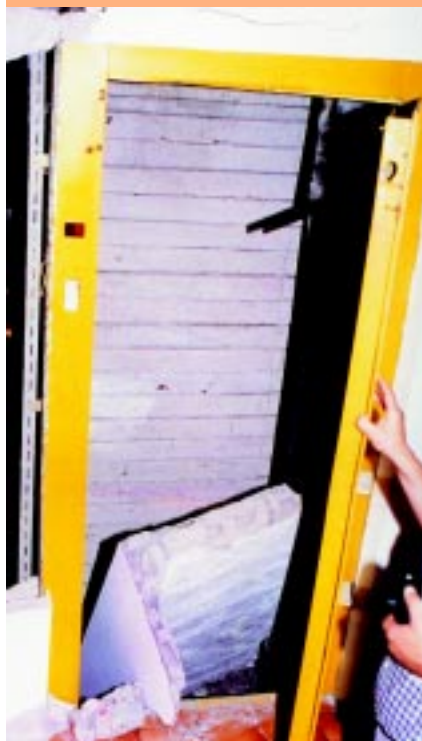
Dstrucción de una cabina de ascensor por desprendimiento de material al interior del ducto (Ecuador, 1998).
