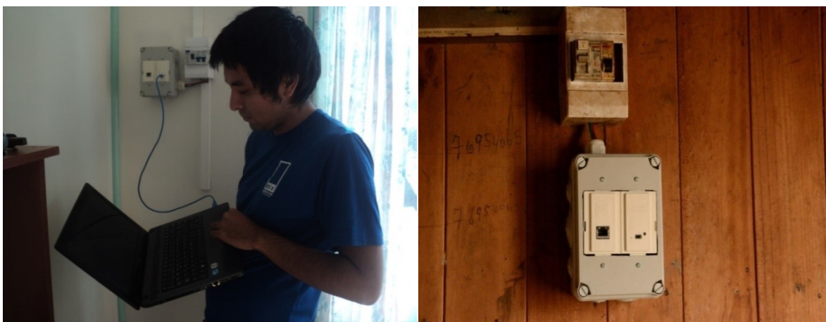
Figura 24. Instalación de medidores inteligentes en la comunidad de Huanaco Huenchun.
